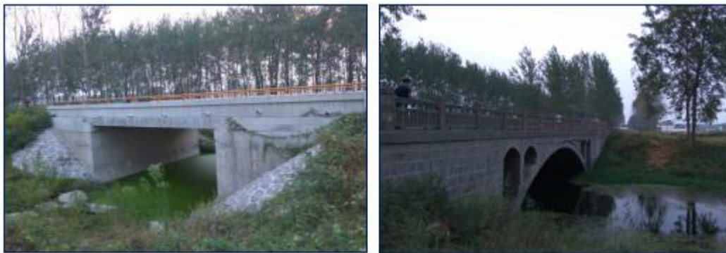
图 3.2-3 X022 桥梁现状
